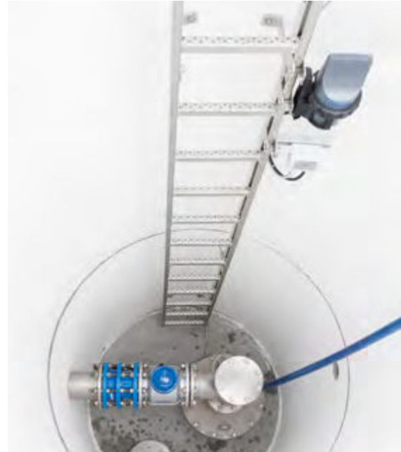
GSM/GPRS haberleşmeli pille çalışan IP68 ölçüm noktası
