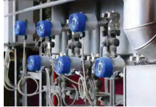
Bir enerji santralinde OPTIBAR DP 7060 fark basınç transmitterleri
