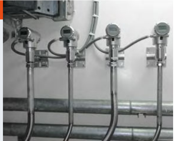
Işınlanmış ortamda kondensatların TDR seviyesi ölçümü
