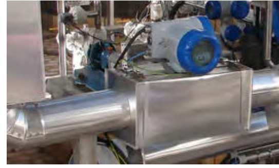
Sülfürik asidin seyreltilmesi için akış ve konsantrasyon ölçümü
