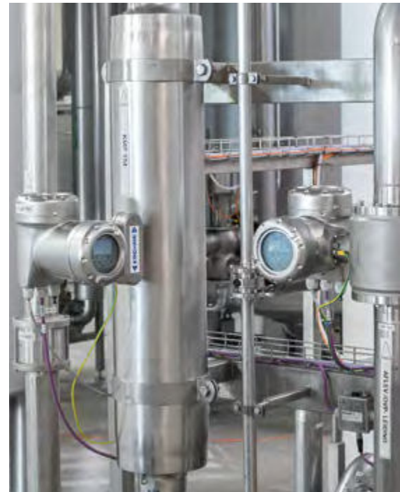
Kesme duyarlı akışkanlar için OPTIMASS düz tüplü kütsel akışölçer
