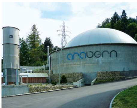
Biogas-Messung für die Versorgung eines Blockheizkraftwerks, ara region bern ag, Schweiz
