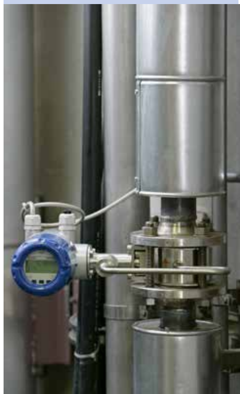
Installation d'un OPTISWIRL 4070C dans une brasserie
