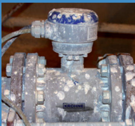
OPTIFLUX 5000 : tube de mesure en oxyde de céramique utilisé dans l'industrie chimique
